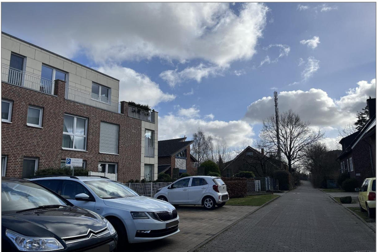
Abbildung 14: Blick auf die Marienstraße mit mehrgeschossigem Wohngebäude innerhalb des Plan-gebiets (Blickrichtung Süden).
