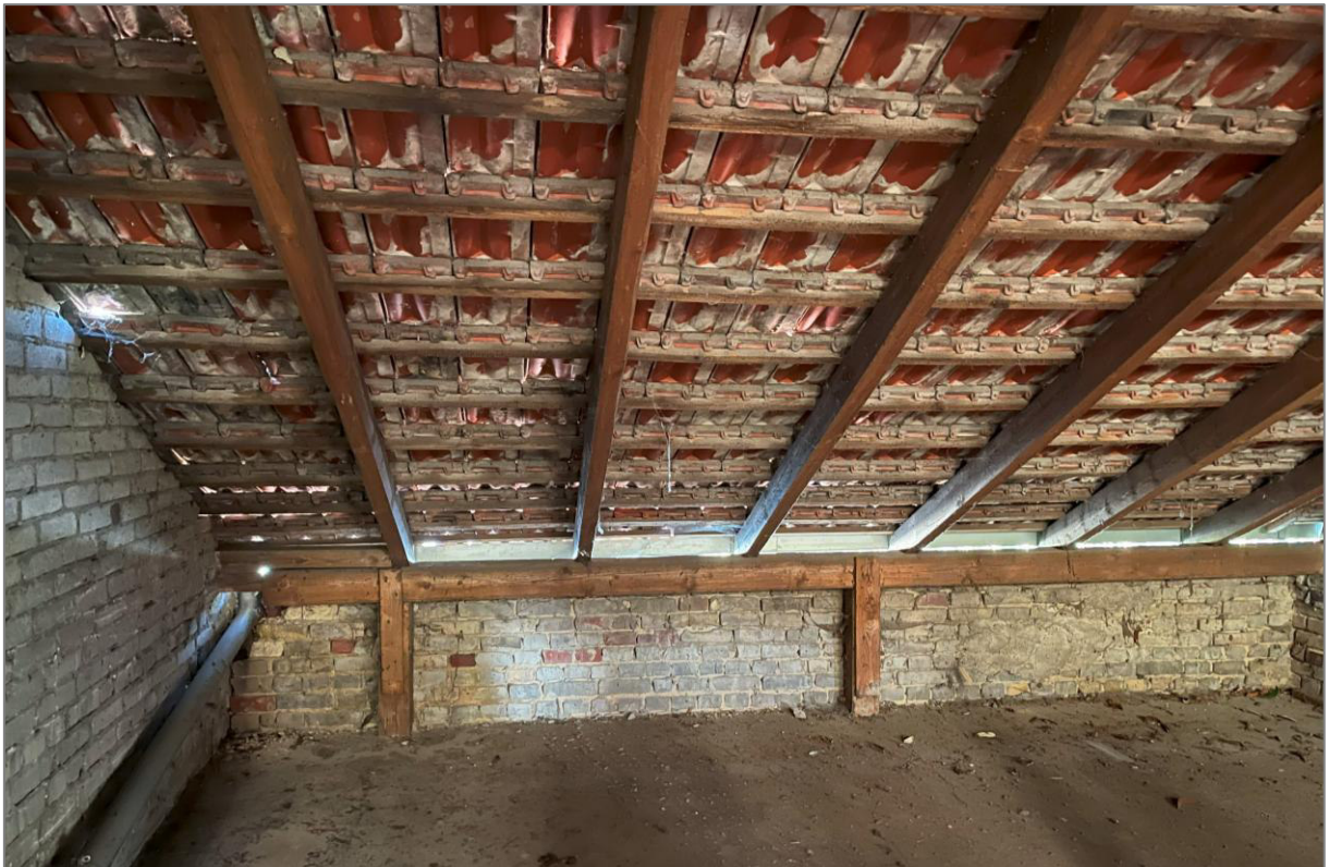
Abbildung 12: Blick auf den Dachboden der Halle im südöstlichen Plangebiet.
